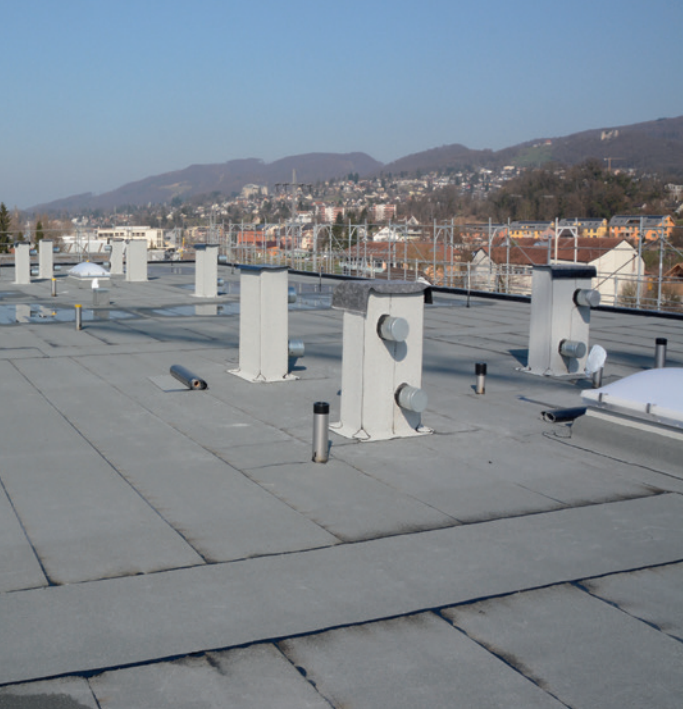
Fertig verarbeitete 2. Lage mit swissporBIKUTOP ECO EP5 S flam Fertig montierter Anschlusspunkt ASP
