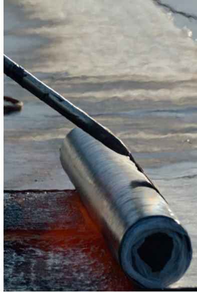
Vollflächiges aufschweissen der Dampfbremse swissporBIKUPLAN ECO EGV3.5 v flam
