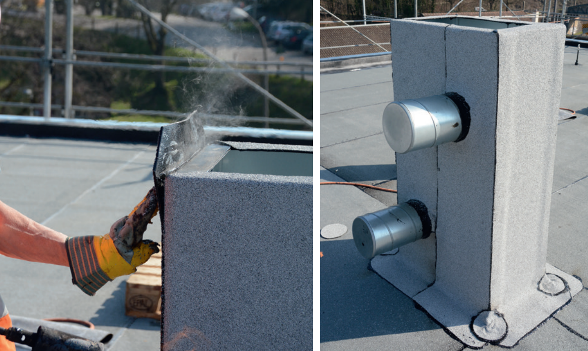
Einfassung der Lüftungshauben mit swissporBIKTUOP ECO EP5 S flam
