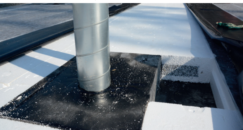
5 v flam, lose verlegt, Überlappungen verschweisst
