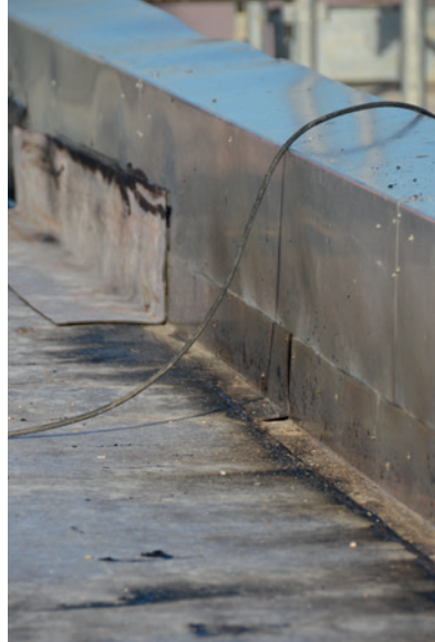
Dampfbremse im Aufbordsbereich
