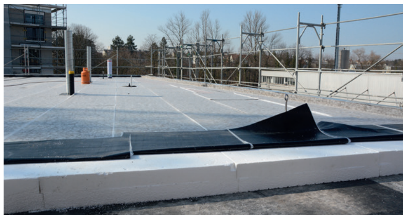
Fertig verlegte Dämmung swissporEPS 150 ECO mit 1. Lage swissporBIKUPLAN ECO EGV3.
