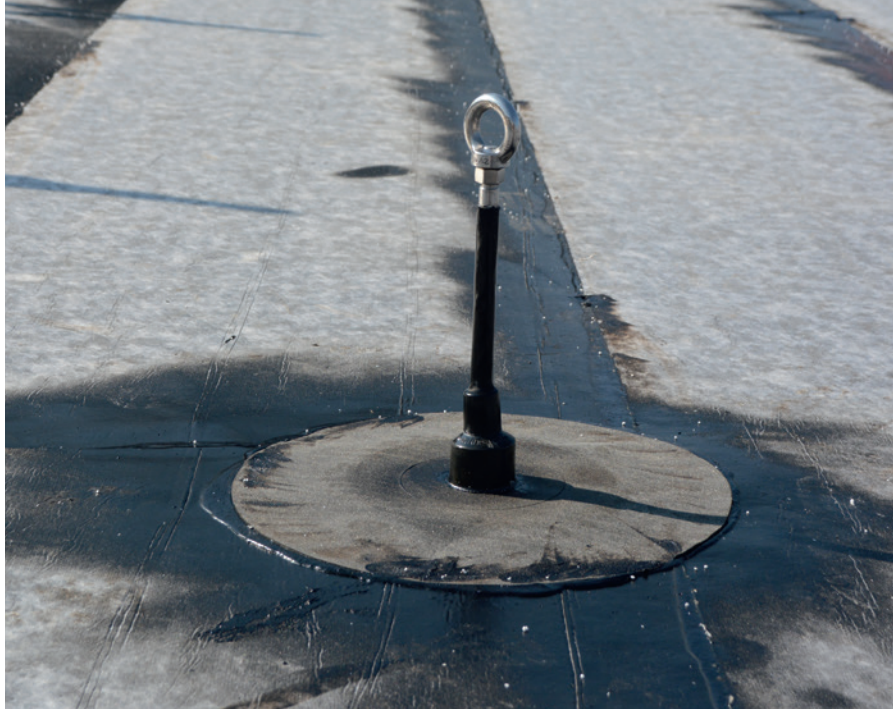
Fertig verarbeitete 2. Lage mit swissporBIKUTOP ECO EP5 S flam Fertig montierter Anschlusspunkt ASP
