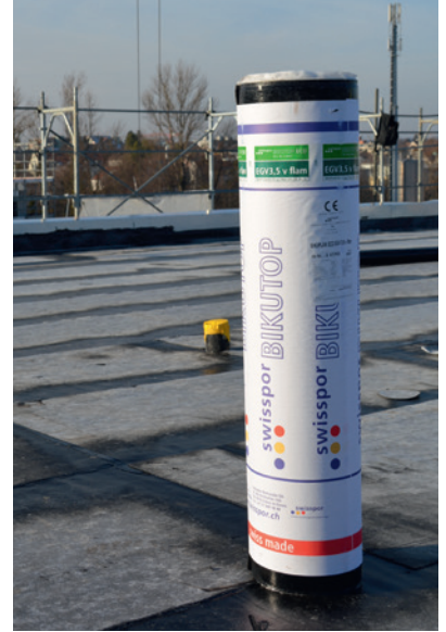
Fertig verarbeitete Dampfbremse
