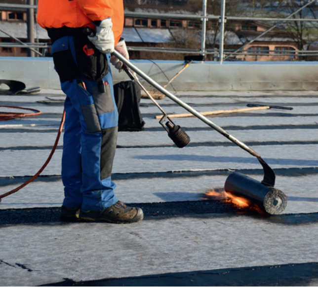
Vollflächiges aufschweissen der Dampfbremse swissporBIKUPLAN ECO EGV3.5 v flam
